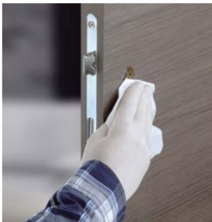
Nettoyez/dégraissez soigneusement la partie de la porte en contact avec la rosace, ou la plaque (uniquement avec le chiffon dégraissant fourni dans l'emballage).
