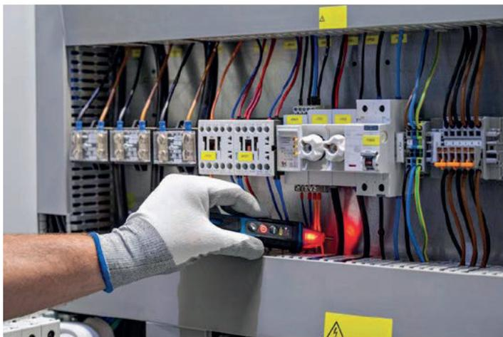
Le GVD 1000-17 Professional convient aux chantiers exigeants grâce à son indice de protection IP67 contre la poussière et les projections d'eau et son boîtier robuste et caoutchouté qui le protège contre les chutes jusqu'à 2 m de hauteur.
