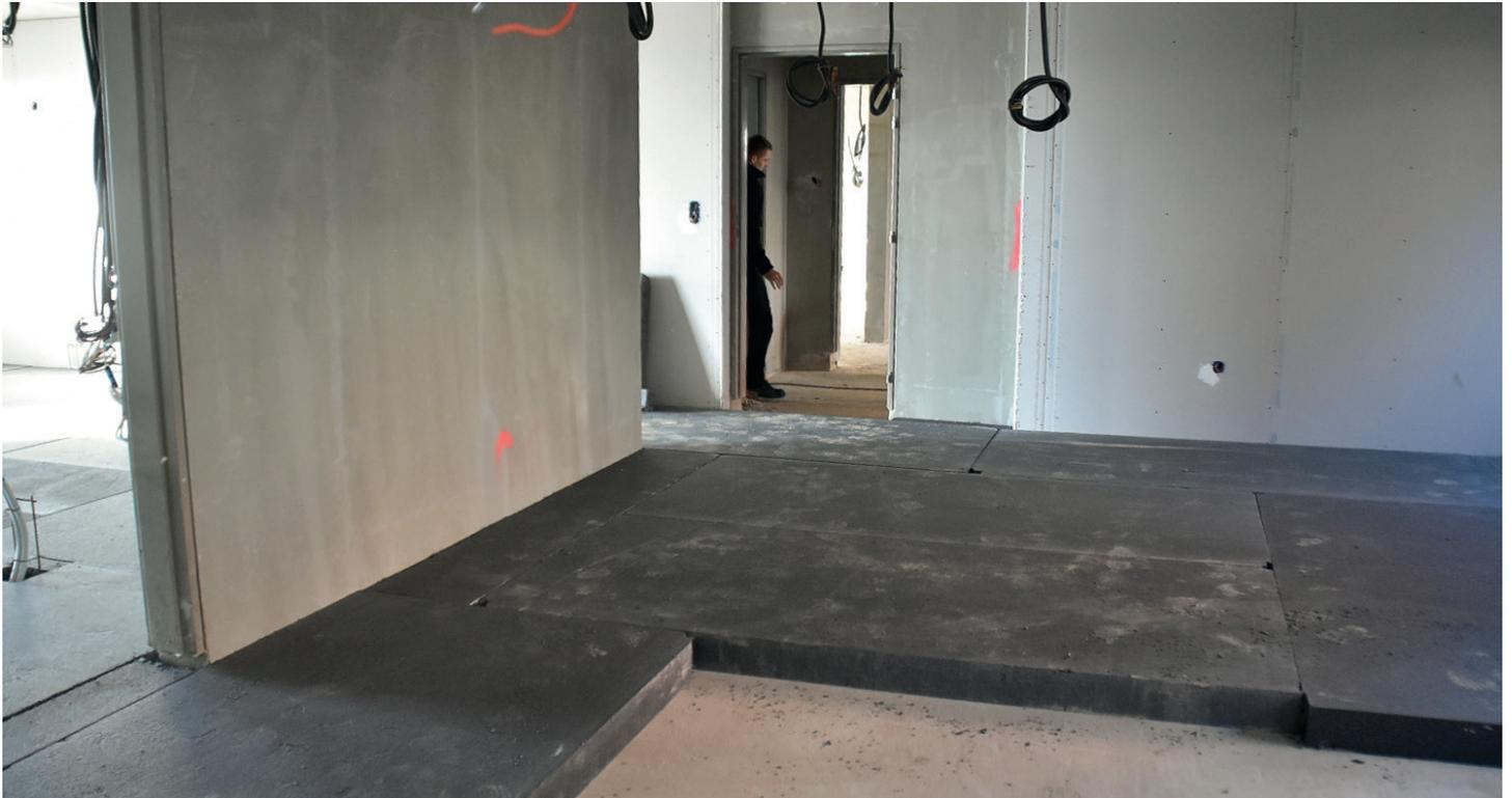
HIRSCH Isolation enrichit sa gamme d'isolants sous chape et sous dallage avec Maxidall Ultra, des panneaux en polystyrène expansé graphité offrant des performances thermiques parmi les plus élevées du marché, tout en affichant un poids carbone réduit.
