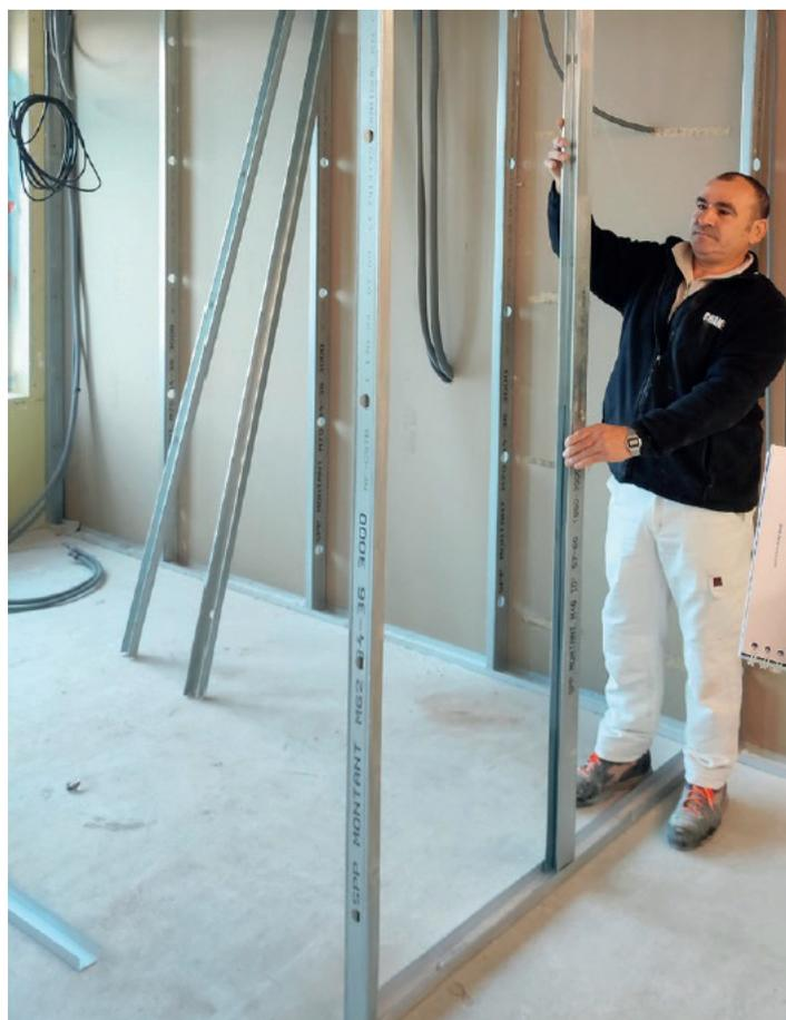
une réduction du temps de pose de 50 %. La suppression des découpes avec disqueuse limite les risques d'accidents et garantit un environnement de travail plus sûr et une meilleure continuité des travaux.
