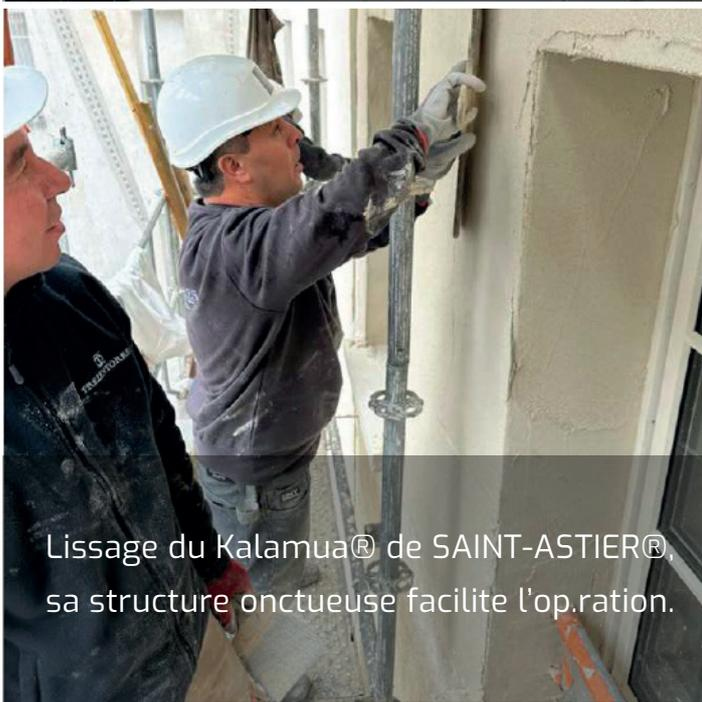
Lissage du Kalamua® de SAINT-ASTIER®, sa structure onctueuse facilite l'opération.
