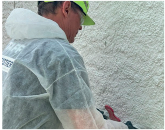
Dressage de l'enduit de finition NOVASKIN® Finish.
