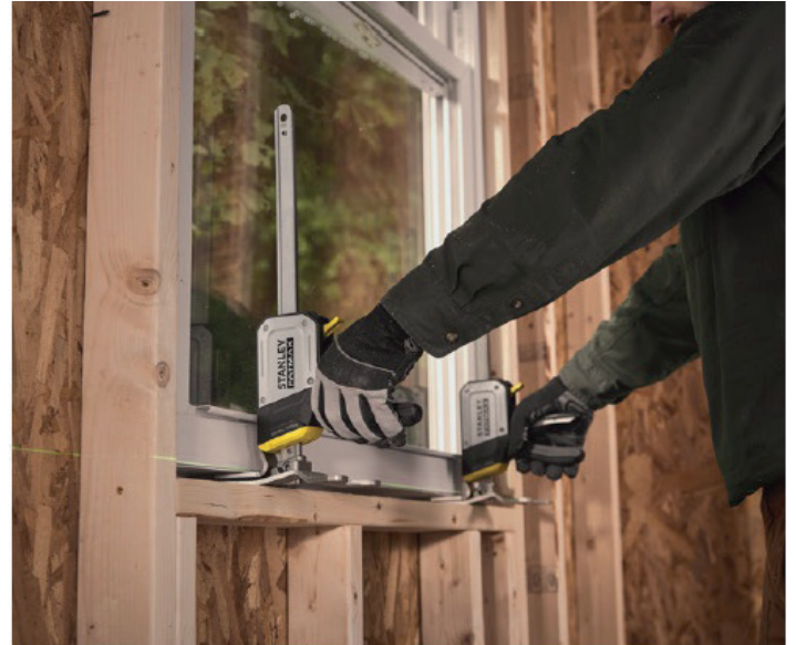
Pose de portes et de fenêtres
