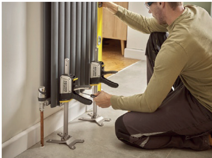
Pose de radiateur/chauffe-eau
