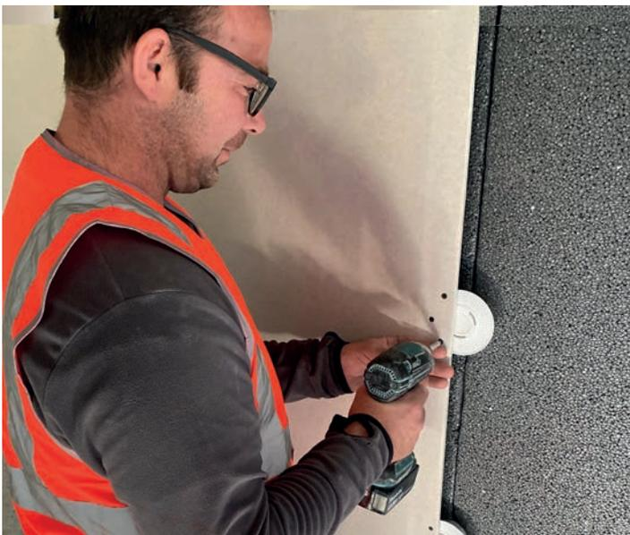
des panneaux PSE de 160 mm d'épaisseur), répondant parfaitement aux exigences de la RE2020. Le système est conçu pour intégrer des panneaux d'isolation PSE jusqu'à 160 mm d'épaisseur et 3 m de haut.
