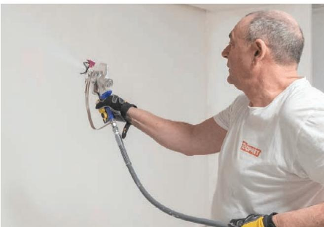
Le nouvel enduit TOUPRET AIRSPRAY® F ICE permet d'obtenir une façon unique, très soignée sur des supports bruts ou peints, qu'ils soient neufs, rénovés ou révisés : plâtre, carreaux de plâtre, plaques de plâtre, anciens fonds peints, tous types d'enduits, ciment, béton.
