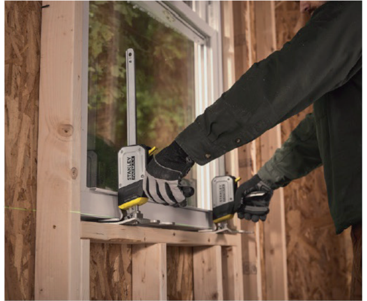
Pose de portes et de fenêtres
