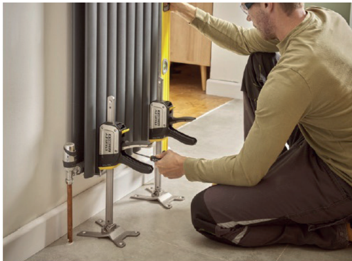
Pose de radiateur/chauffe-eau
