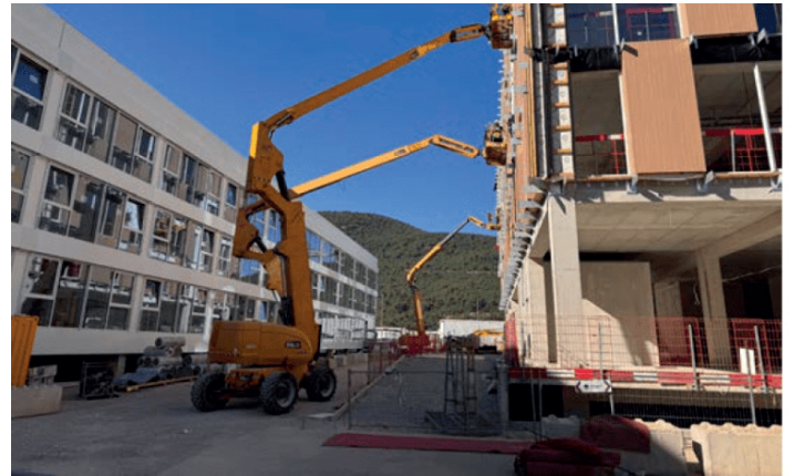
© Groupe Lorillard - sur le bâtiment de droite, pose des façades à ossature bois positionnés au nu extérieur, qui viennent s'ajouter ponctuellement en façade.
