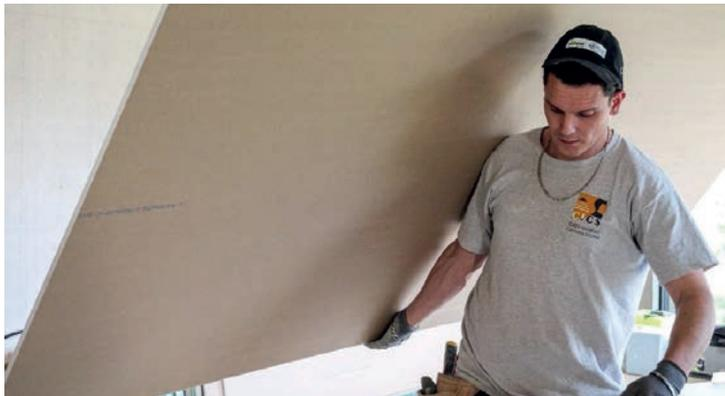
chauffeur pourra installer 25 palettes de Placo® Plume 13 contre 21 de Placoplatre® BA13.
